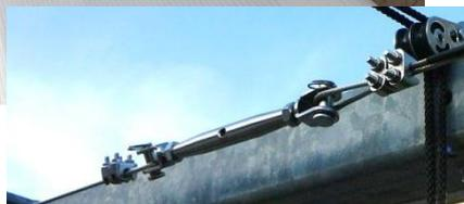
Durch den Wantenspanner wird das Stahlseil straff gespannt, um ein „Durchhängen“ des Baldachinsegels zu vermeiden.
