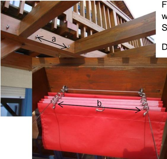
Für jedes Segelfeld werden vier Ringmutter benötigt, welche als Halterung und als Eckpunkte für das Stahlseil genutzt werden.
