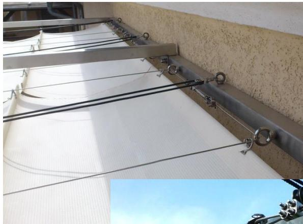
Wenn die Vorbereitungen beendet sind, kann das Stahlseil durch die vier Ringmutter gezogen werden. Verbinden Sie die Stahlseilenden zum Schluss mit Hilfe eines Wantenspanners und 4 Seilklemmen. Optisch schöner wirkt es, die Spanner außerhalb des Blickfeldes am hinteren Ende zu platzieren.
